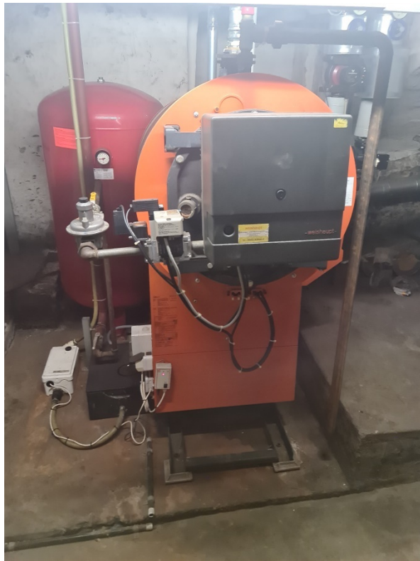
Wärmeerzeuger Quelle: Privat, Aufnahmedatum: 17.08.2023
